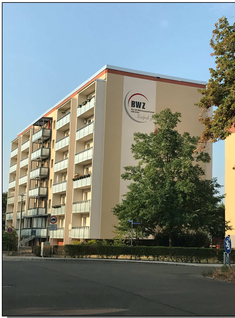
neu sanierter Wohnblock Am Weinberg 4
