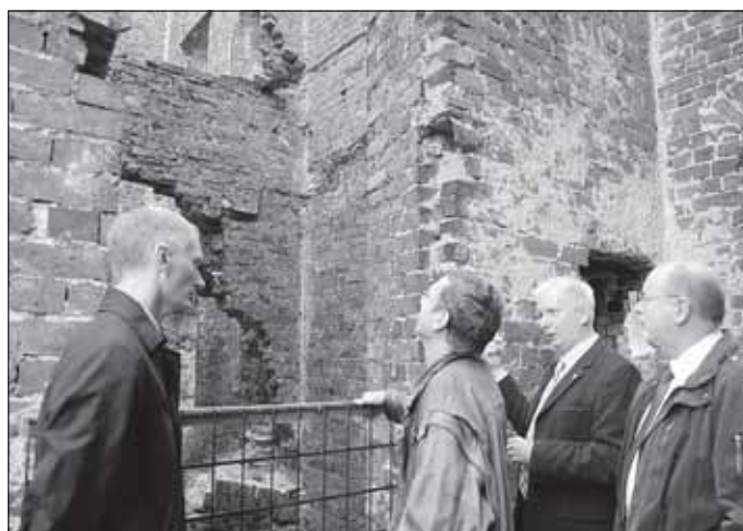
Zum zweiten Mal in diesem Jahr konnte der Förderverein Schloss Zerbst zum offiziellen Start für eine Baumaßnahme einladen. Foto: Helmut Rohm
