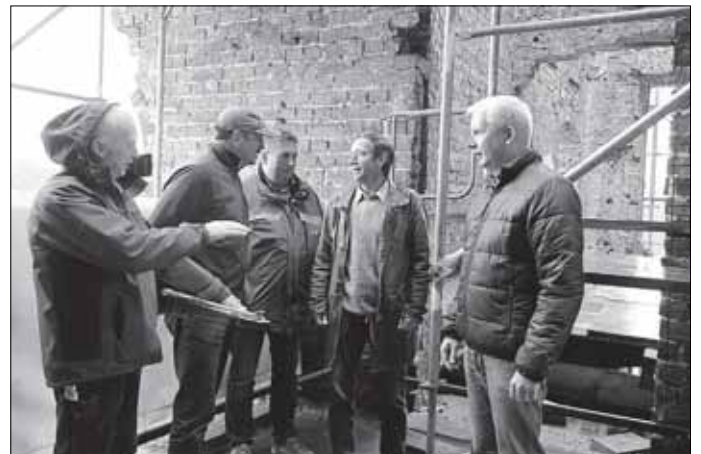
Baubesprechung zur aktuell laufenden Sicherungsmaßnahme im Zerbster Schloss: (v. l.) Bauleiter Alfred Graßhoff, Rüdiger Willno, Geschäftsführer der Zerbster Firma „Heidetor“, Christian Keck, Stellvertretender Vorsitzender des Fördervereins Schloss Zerbst, Architekt Lutz Mengewein und Vereinsvorsitzender Dirk Herrmann. Foto: Helmut Rohm
