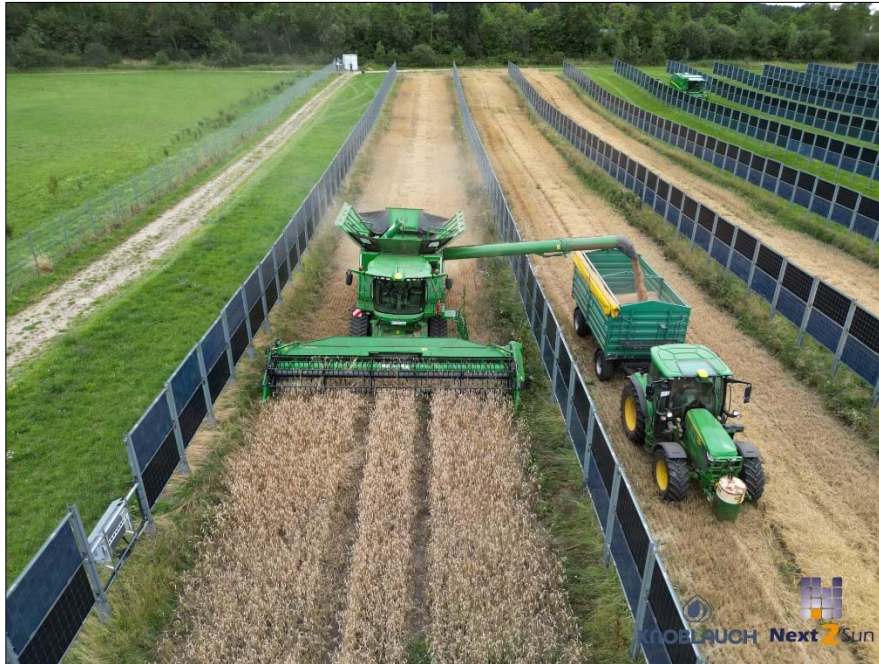
Abbildung 4: Prinzip der AGRI-Photovoltaikanlage (Quelle: NEXT2Sun / Knoblauch GmbH)
