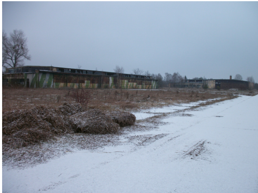
Bild 3: Blick auf den Anlagenstandort
