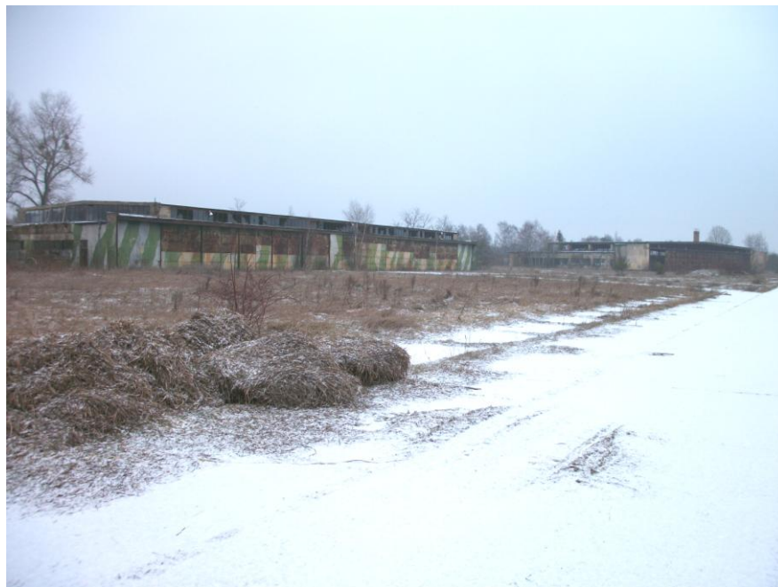
Bild 3: Blick auf den Anlagenstandort
