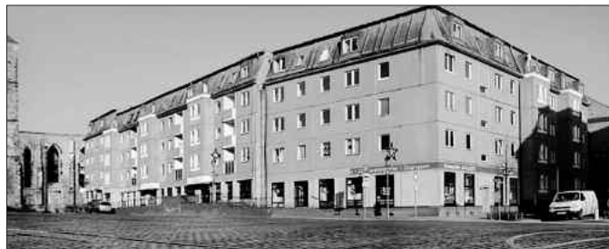
Zerbst Markt Ecke Brüder Str. vor der Sanierung
