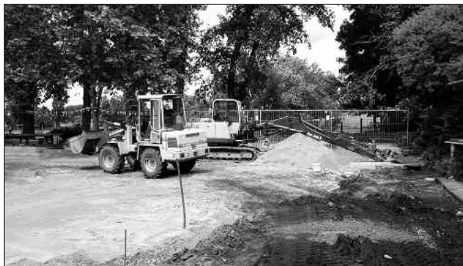
Vorbereitungsarbeiten für die neue Pflasterung auf dem Schulhof der „Astrid-Lindgren-Grundschule“ am Amtsmühlenweg
